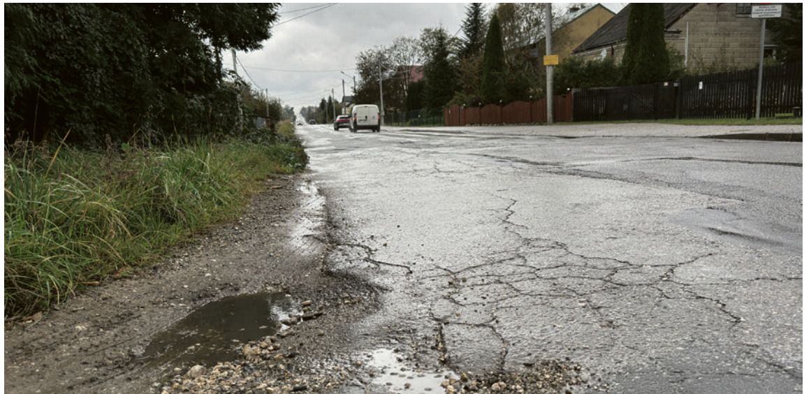
● W ramach kompleksowej modernizacji pięciu ulic na peryferyjnych osiedlach drogowcy wyremontują między innymi ul. Sukowską. Poprawi się tam zarówno komfort kierowców oraz bezpieczeństwo pieszych.
