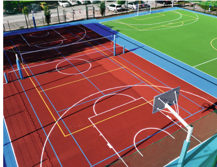
● Przy ulicy Kredowej na terenie osiedla Ślichowice powstał nowoczesny kompleks sportowy. Zastąpił zniszczone, asfaltowe boiska.
